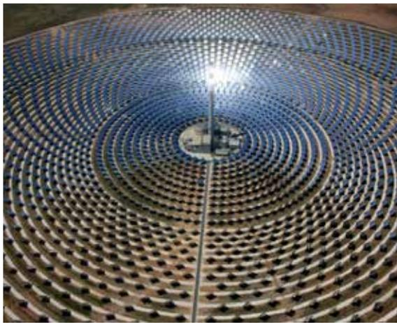
Gambar 3 – Concentrating solar power plant dengan solar tower pada posisi center untuk menerima hasil refleksi energi dari heliostat-heliostat disekitarnya. (Sumber: seia.org)
