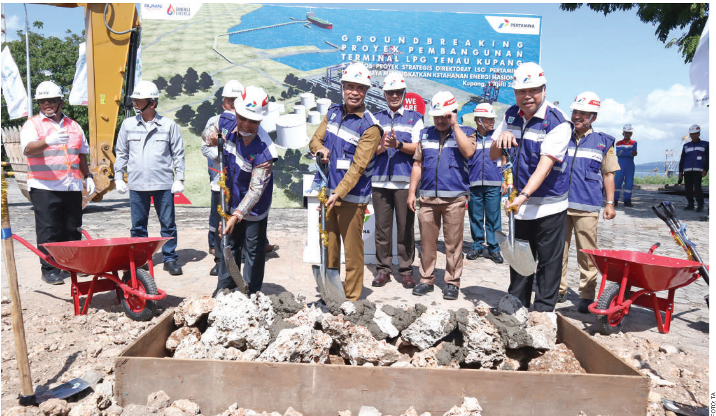
Direktur Logistik Supply Chain & Infrastruktur PT Pertamina (Persero) Gandhi Sriwidodo, anggota Komisi VII DPR RI Ferry Kase, dan Gubernur NTT Viktor Laiskodat bersama-sama melakukan peletakan batu pertama saat Groundbreaking Proyek Pembangunan Terminal LPG Tenau, Kupang. Senin (1/4/2019).
