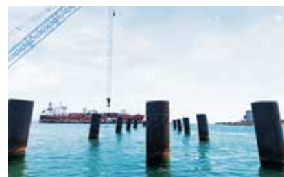
Pemasangan tiang pancang untuk pembuatan Trestle Jetty yang disandarkan kapal berkapasitas 25.000 DWT
