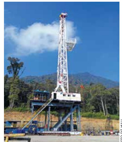
Rig N110M3-28 saat mengebor Sumur HLS-E/1 di Proyek Hululais.
