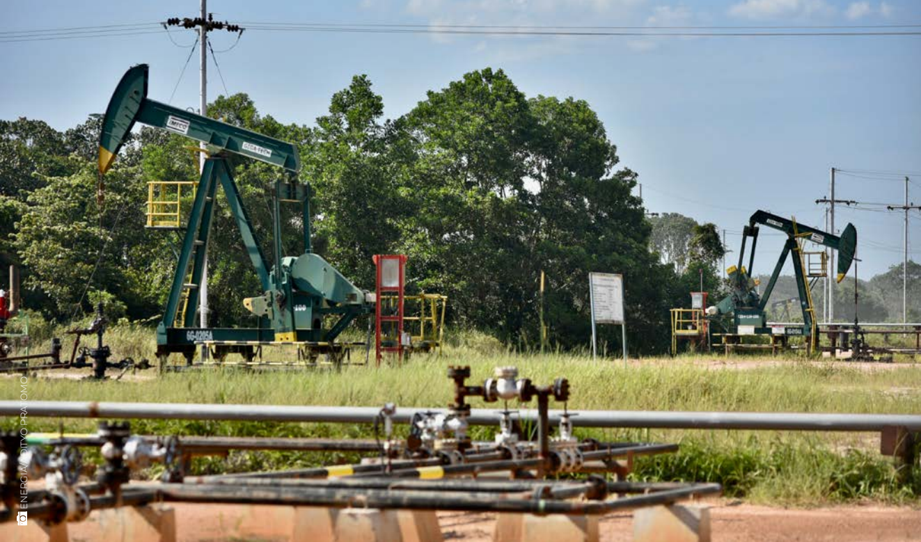
Tampak dua pompa angguk dan jalur pipa salah satu sumur di wilayah Duri Pertamina Hulu Rokan. Two pumps and a pipe line from one of the wells in Duri Pertamina Hulu Rokan area can be seen.
