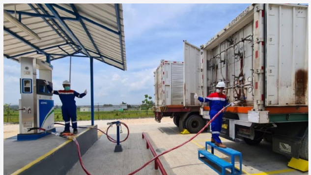
Proses kompresi hingga pengisian CNG ke truk pengangkut di area Mother Station
