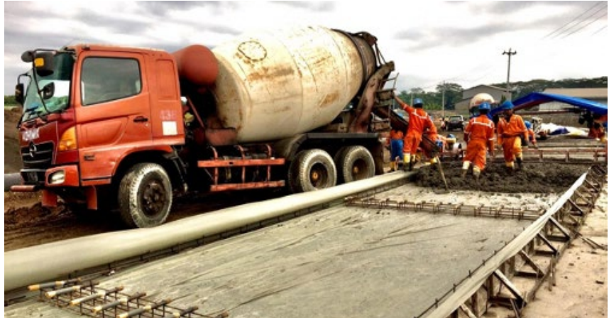
Pengecoran "Rigid Pavement" Jalan MT Haryono baru sesuai hasil kesepakatan Detail Engineering Design yang telah disetujui oleh Balai Besar Jalan Nasional Jalan Nasional Propinsi Jateng - DIY Kementerian PUPR.
