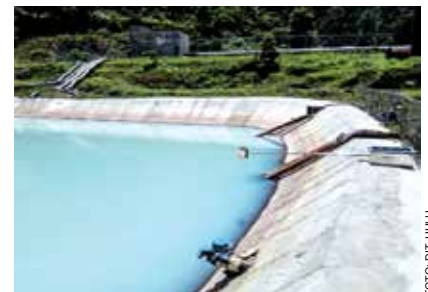
Pengukuran level cooling pond menggunakan PELET
