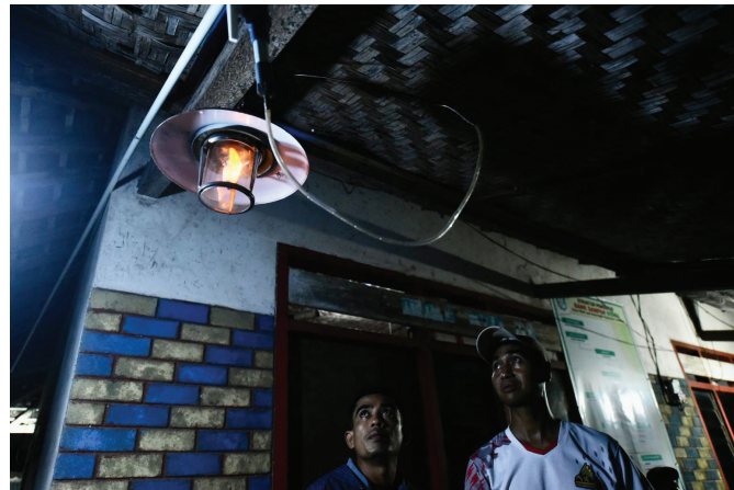
Seorang Warga melihat proses nyala lampu berbahan bakar Biogas Makro Alga di salah satu rumah di Dusun Belet Lauk, Desa Bagik Payung, pada Kamis (8/12/2022).
