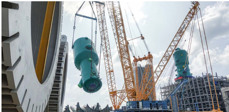
Proses pemasangan Disenganger/Stripper di proyek RDMP Balikpapan.
