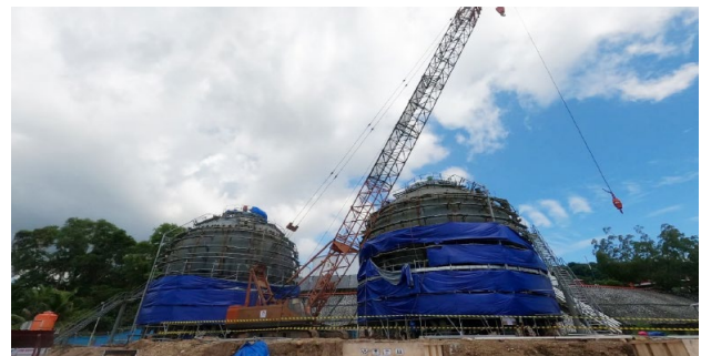
Gambar 4. Pembangunan TLPG Jayapura
