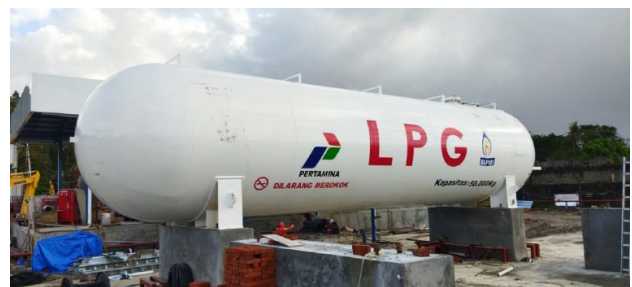
Gambar 5. Pembangunan SPBE Wayame
