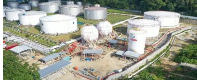
Gambar 3. Pembangunan TLPG Wayame
