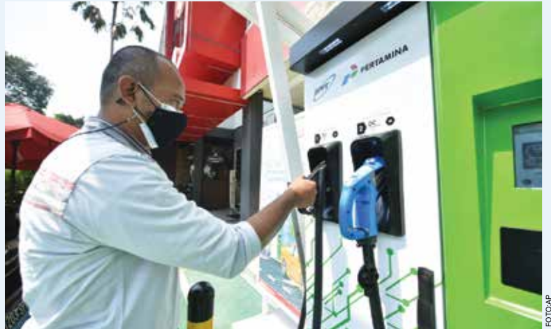
SPKLU Pertamina bertipe fast charging dapat mengisi EV hingga penuh dalam waktu 30 menit - 1 jam.
