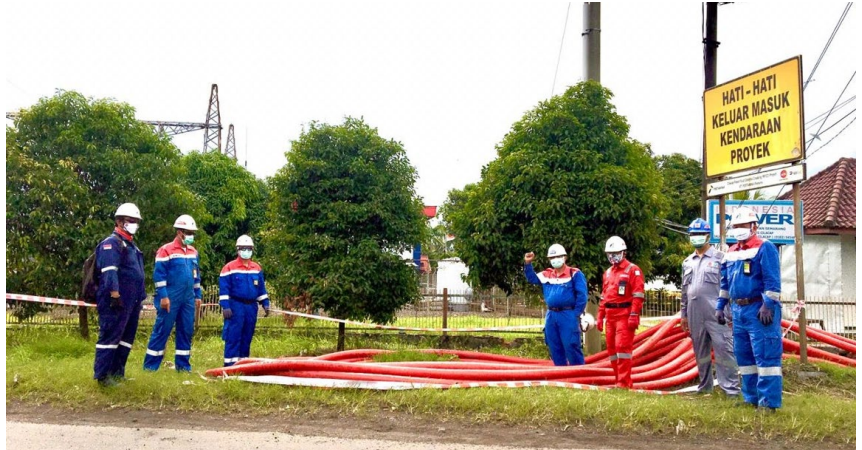
Tinjauan lokasi di area pembangunan jaringan listrik baru 20 kva, sesuai kesepakatan relokasi jaringan listrik existing milik PT PLN, yang terdampak proyek RDMP RU IV.
