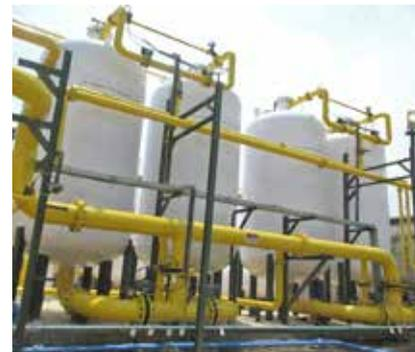
Unit *Pressure Swing Adsorption* (PSA) sebagai alat pemisah kandungan CO<sub>2</sub> dalam natural gas, PEP Asset 3 Jatibarang *Field*
