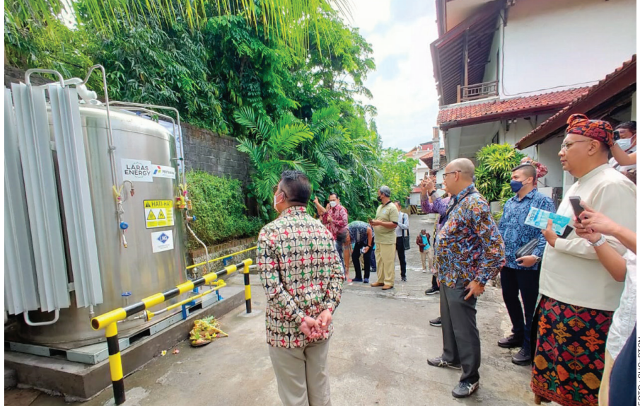
Liquefied Natural Gas (LNG) Hotel SOL by Melia di Benoa, Bali dikemas dalam bentuk micro bulk .
