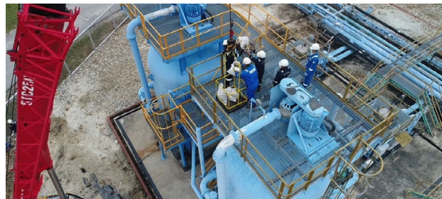
Penggantian pecan dan walnut ke cangkang kemiri di nutshell filter Pedada
