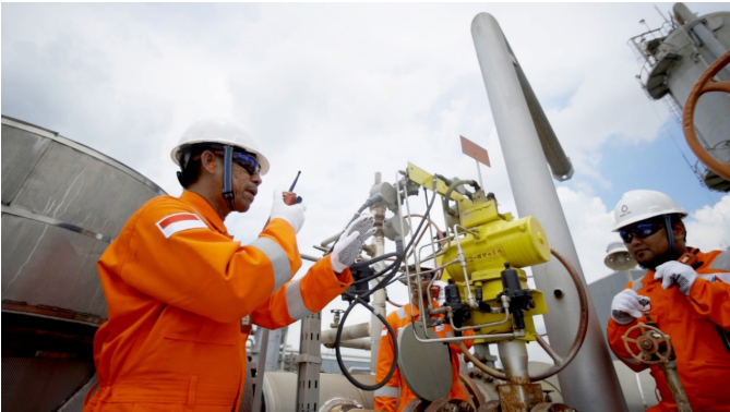
FOTO: SHU-BADAK LNG
