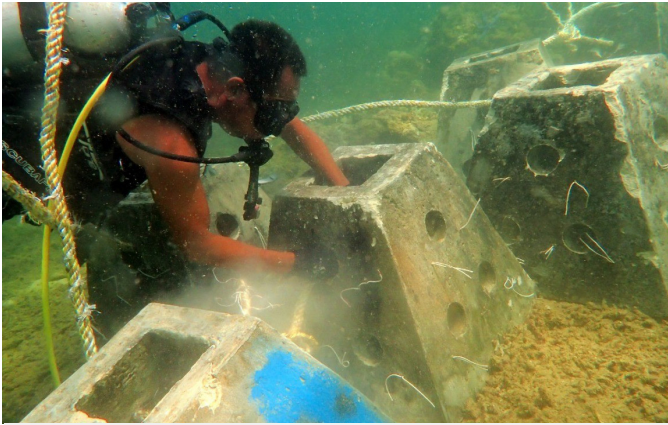
Coral Reef Barrier dibuat dengan mengkombinasikan concrete block sebagai terumbu buatan dan tali daur ulang bekas kapal dari program Balanipa, yang merupakan program CSR PHSS lainnya sebagai media transplantasi gantung.
