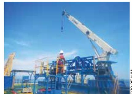
Instalasi *modular crane* menggunakan *smart boom basket*.
