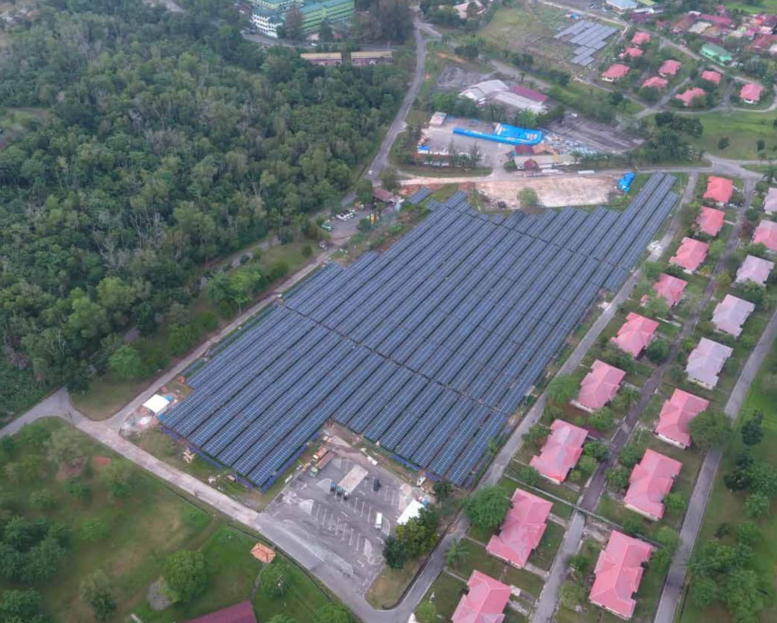
Pertamina NRE berhasil memasang ribuan surya panel terpasang di wilayah kerja Pertamina Hulu Rokan sebagai kontribusi Pertamina Group untuk pengurangan emisi.
