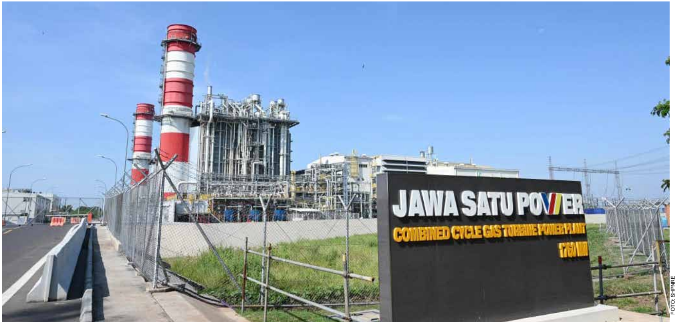
Pembangkit Listrik Tenaga Gas Uap atau PLTGU Jawa-1 merupakan pembangkit listrik yang terintegrasi dengan FSRU (Floating Storage Regasification Unit) dengan kapasitas terpasang 1.760 Megawatt. PLTGU Jawa-1 dioperasikan oleh PT Jawa Satu Power, perusahaan konsorsium Pertamina NRE, Marubeni, dan Sojitz, Selasa (16/7/2024).
