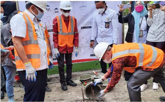
Bupati Kabupaten Administrasi Kepulauan Seribu, Junaedi, di Pantai Sakura, Kelurahan Pulau Untung Jawa, Kecamatan Kepulauan Seribu Selatan, secara simbolis meletakkan batu pertama pembangunan Kampung Jepang di Pulau Untung Jawa, Rabu (10/3).
