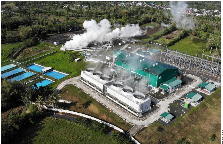
Salah satu area panas bumi yang dikelola PT Pertamina Geothermal Energy
