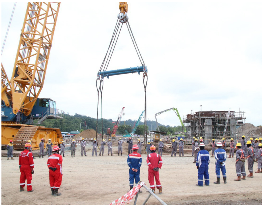
Persiapan pemasangan Alkylation Reactor.
