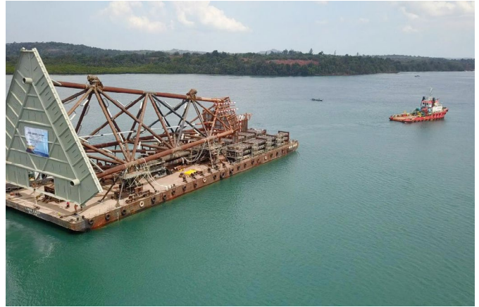
Jacket (kaki) anjungan lepas pantai untuk proyek Jumelai, North Sisi, North Nubi (JSN) milik Pertamina Hulu Mahakam (PHM).
