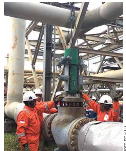
Proses Instalasi recycle valve's cage modifikasi ke unit booster kompresor K-4920.
