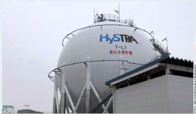
Tangki penyimpanan hidrogen cair yang dibangun oleh Kawasaki Heavy Industries di terminal penerima hidrogen di Pulau Bandara Kobe di Kobe, Jepang barat 22 Januari 2021.
