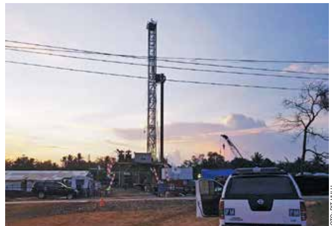
Situasi kegiatan di area pengeboran sumur SBJ-334 Sangasanga Field, Kaltim. FOTO: DIT. HULU
