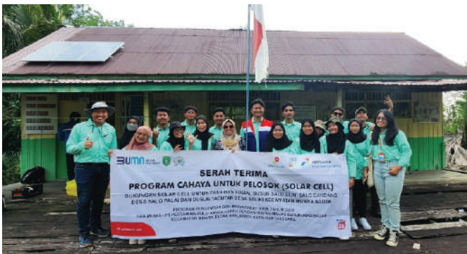
Penyerahan Cahaya untuk Pelosok ( Solar Cell ) untuk Dusun Salo Bandang, Desa Salo Palai, Kecamatan Muara Badak.
