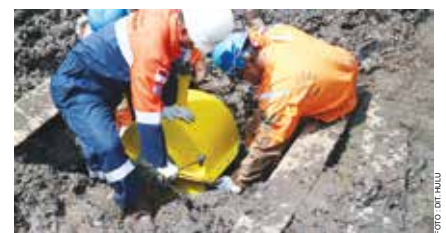
Proses Pemasangan stud bolt Cover JAM CERDAS di jalur SKN-NGF, PHE JOB PTJM, Sumatera Selatan.
