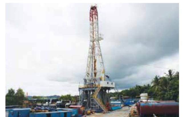
Lokasi pengeboran sumur pengembangan B-175 Bunyu Field, Pulau Bunyu.
