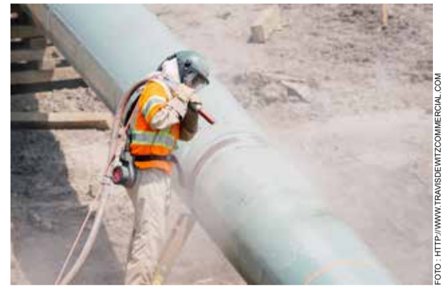
proses pekerjaan sandblasting
