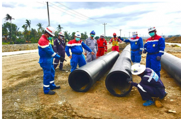
Tinjauan Lokasi di Area Pembangunan Baru Jaringan Air Minum Perkotaan diameter 630 mm di Area baru sebagai hasil Kesepakatan Relokasi Jaringan Air Minum milik Perusahaan Air Minum Daerah Tirta Wijaya Cilacap
